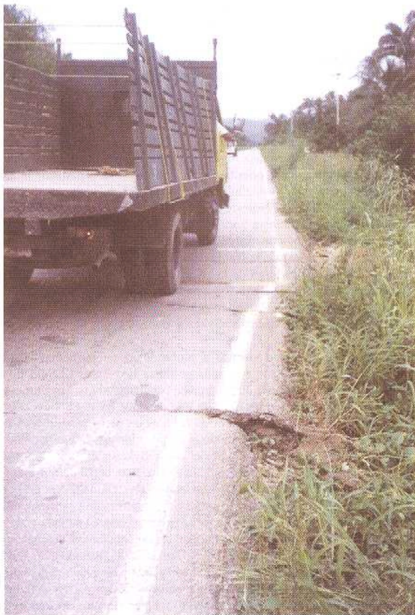
Figura 8. Ruptura cosísmica observada en el sitio S3 en la figura 7, cerca de la población de Casanay, durante el evento sísmico del 9 de julio de 1997 asociado a la falla de El Pilar, oriente de Venezuela.
